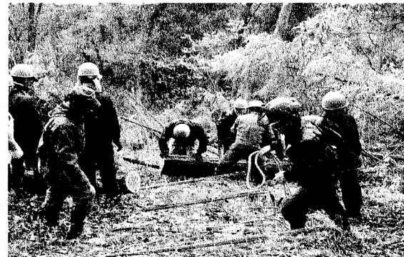
台風による倒木除去作業の様子
