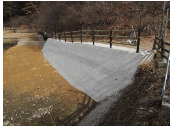
約1／3区間が完成
